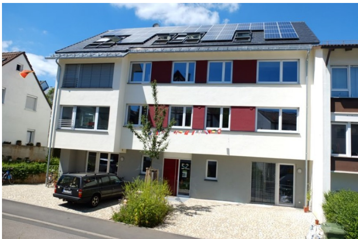
Mehrfamilienwohnhaus in Stuttgart mit Photovoltaikanlage.
