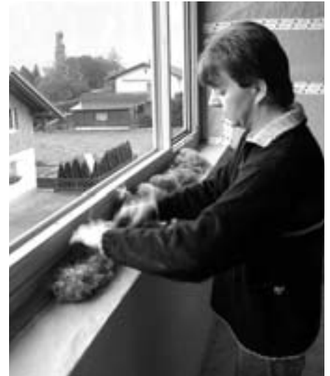
Stopfen der Fenster mit Schafwolle statt Abdichtung mit PU-Schaum.
