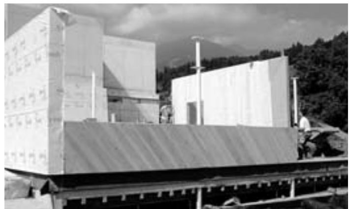
Diagonalschalung in Weißtanne statt Mehrschichtplatte (OSB)
